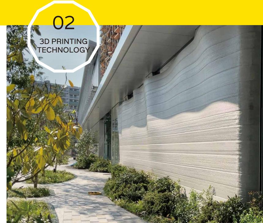
3Dプリンタで製作した曲面形状の外壁。
