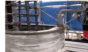
設計データを基に、施工場所で実大構造物を直接印刷できる建設3Dプリンタも登場。巨大なものも現地でシームレスにプリントできます。
