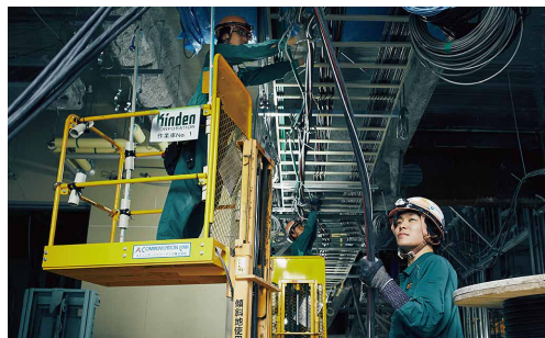
壁や天井の裏側に入り、重要なライフラインである電気配線を行う。
