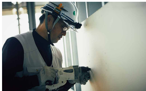
内装は、現場の進行の中心。電気設備や空調設備工事との連携も大切。
